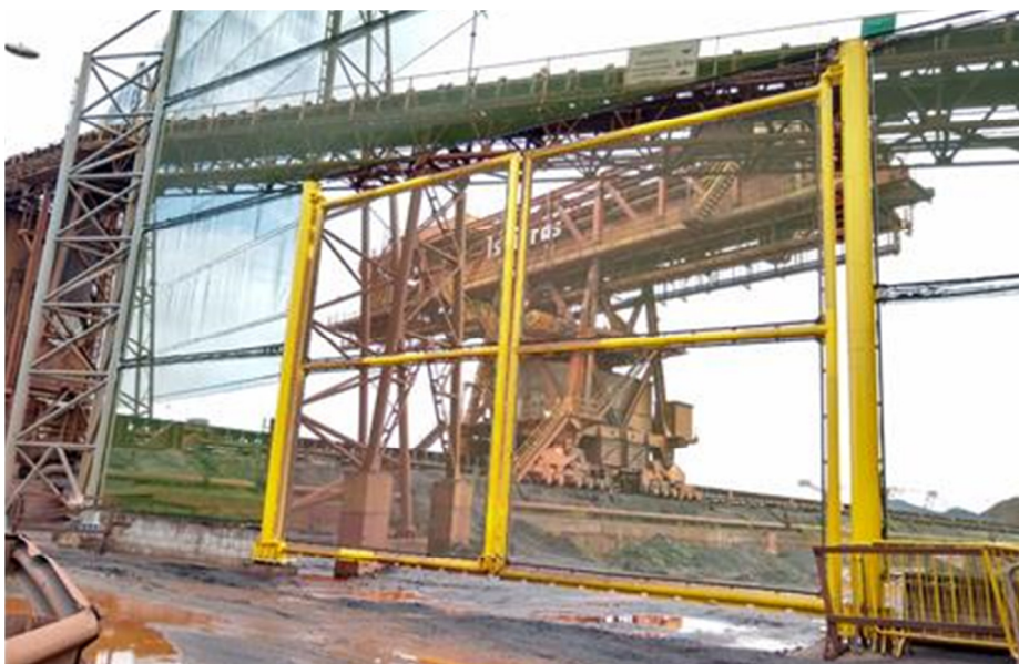
Portão de Acesso à Veículos
