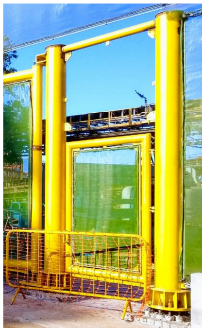
Portão de Acesso à Pedestres
